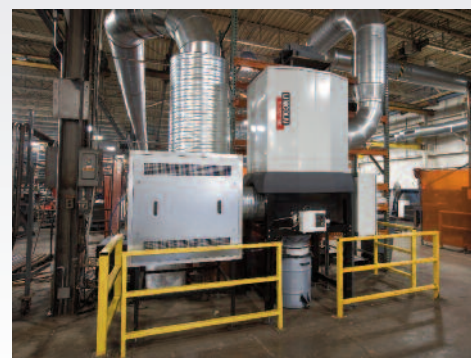
Sistema Push/Pull instalado en la Elgin Sweeper Company
